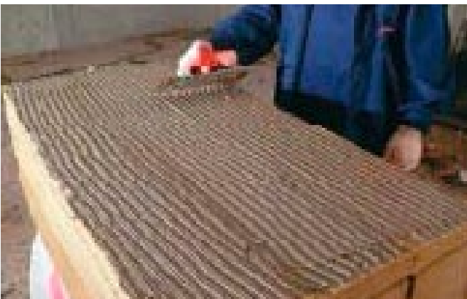
Rozprowadzanie zaprawy packą zębatą
