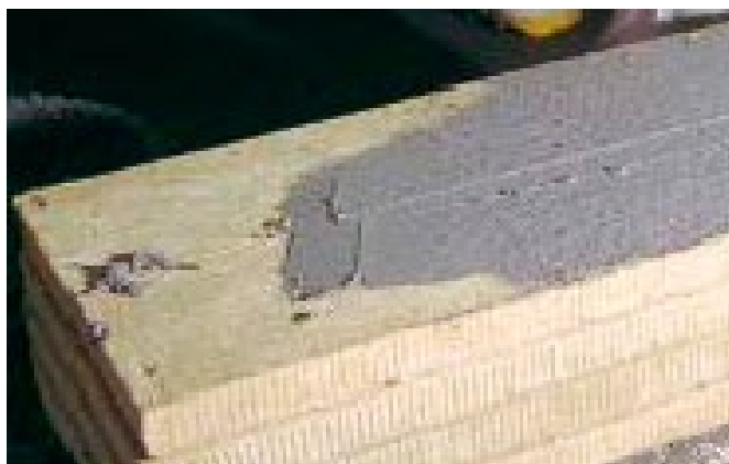
Pokrywanie zaprawą klejową tylnej powierzchni
